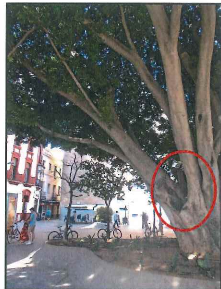
16. Vista sur de la copa. Cimal sobre antiguo desgarro
